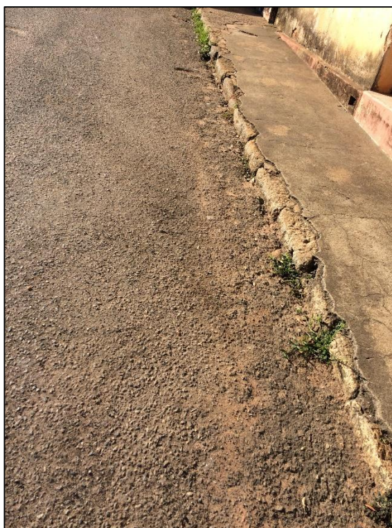
Figura 4.18 – Sarjeta recoberta com CBUQ Fonte: Equipe UNIS, 2017
