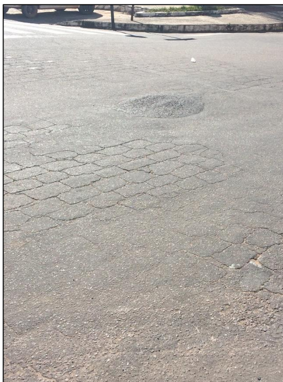
Figura 4.25 – Detalhe PV isolado pela pavimentação Fonte: Equipe UNIS, 2017
